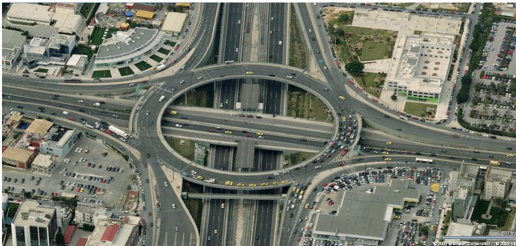
Σχήμα 4-3: Κόμβος Κηφισίας-Αττικής Οδού.
