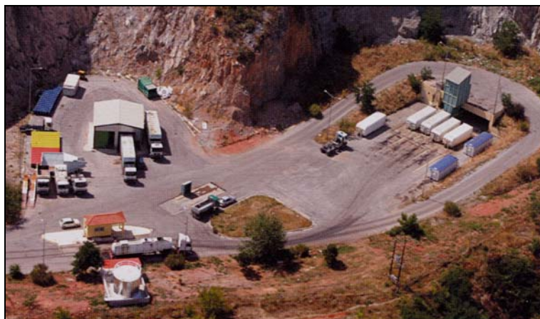
Εικόνα 1.5: Σταθμός Μεταφόρτωσης ΑΣΑ
