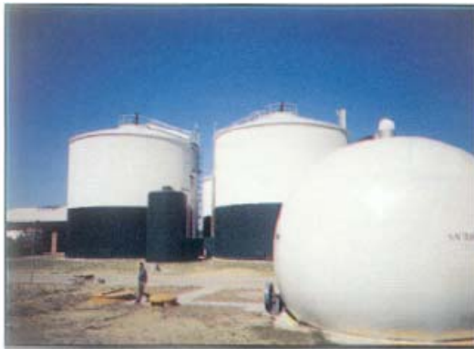
Σχήμα 3.6. Εικόνα αντιδραστήρων αναερόβιας χώνευσης.
